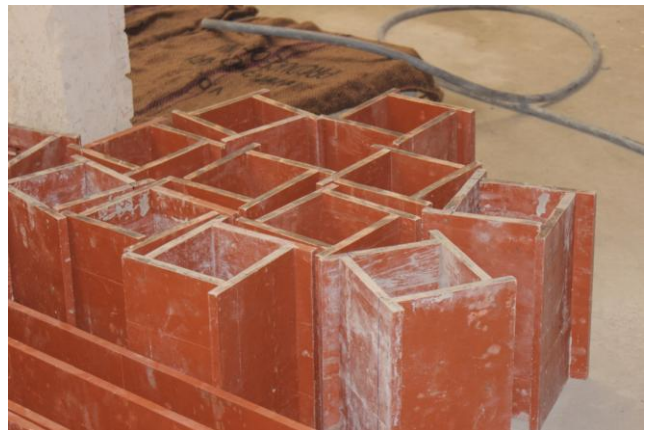
Hình 4: Công tác gia công khuôn mẫu
